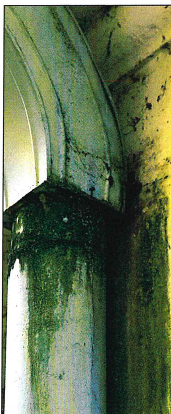
Fot. 17. Fot. 18. Fot. 19. Uszkodzenia tynków ściany wschodniej będące wynikiem uszkodzeń orynnowania i nieodpowiedniego odprowadzania wód opadowych.
