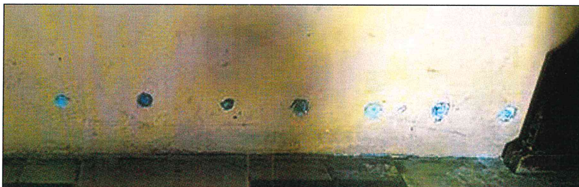
Fot. 4. Iniekcje przeciwwilgociowe wykonane od wnętrza.
