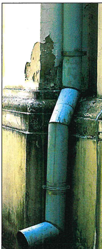
Fot. 17. Fot. 18. Fot. 19. Uszkodzenia tynków ściany wschodniej będące wynikiem uszkodzeń orynnowania i nieodpowiedniego odprowadzania wód opadowych.
