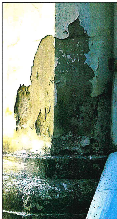
Fot. 17. Fot. 18. Fot. 19. Uszkodzenia tynków ściany wschodniej będące wynikiem uszkodzeń orynnowania i nieodpowiedniego odprowadzania wód opadowych.
